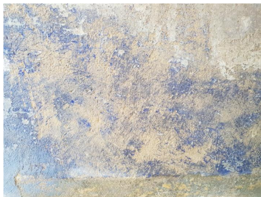
Odkrywki w pomieszczeniu nr 2
