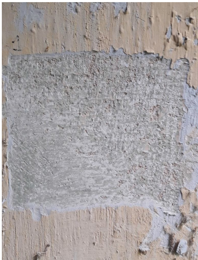
Fot. 2 Odkrywka na ścianie
