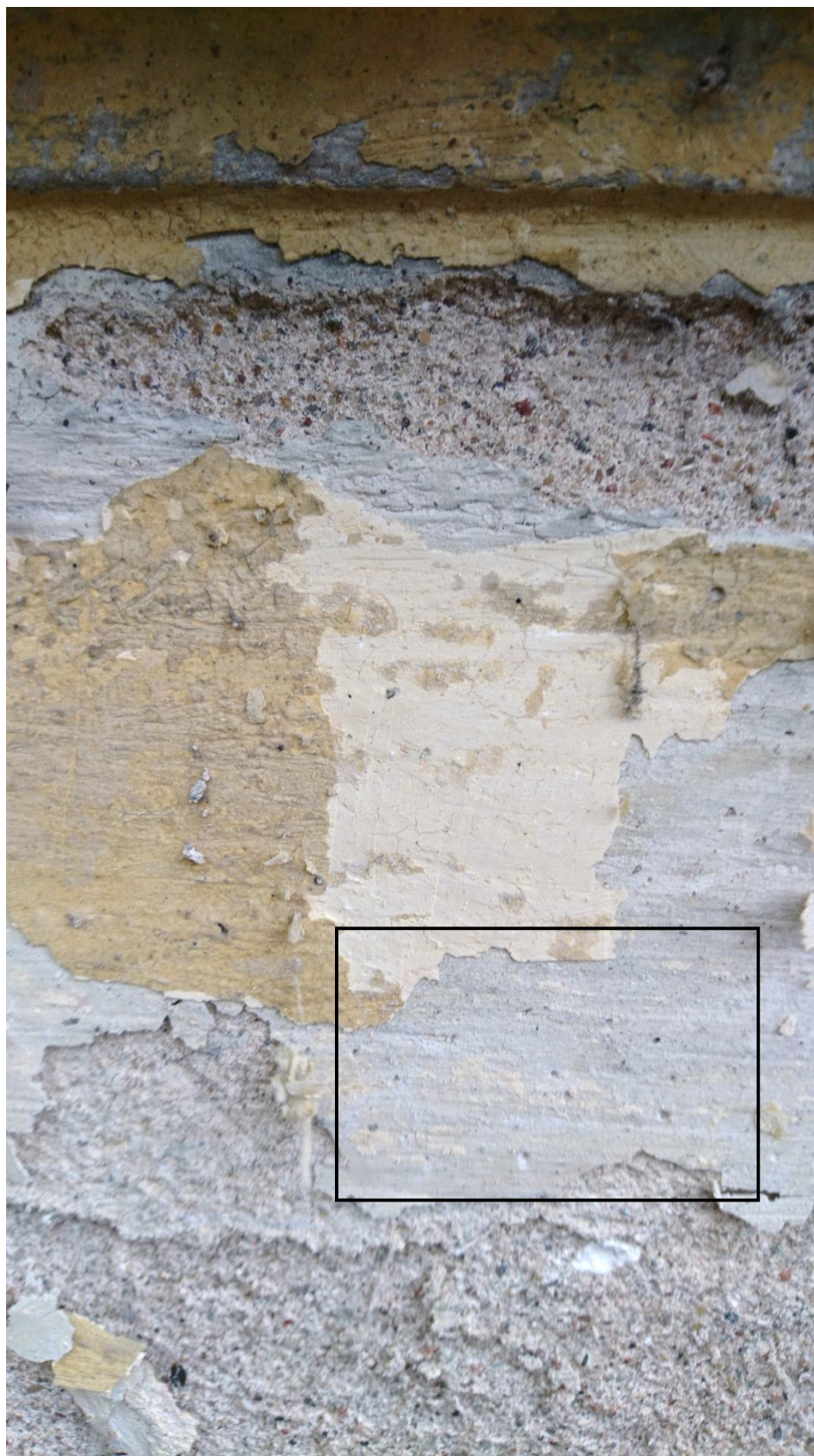
Fot. 1 Odkrywka na ścianie
