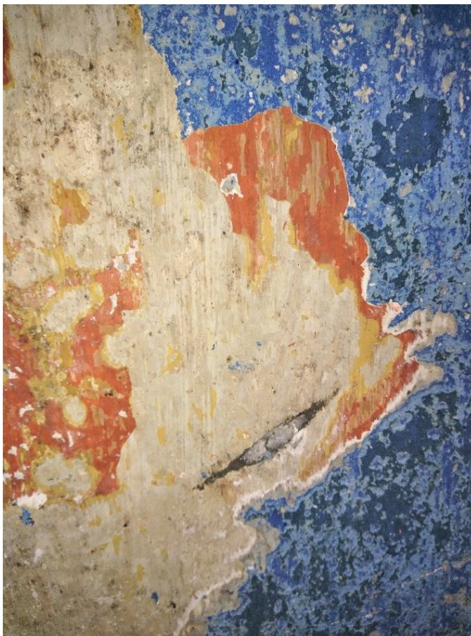
Fot. 9 Odkrywka na ścianie
