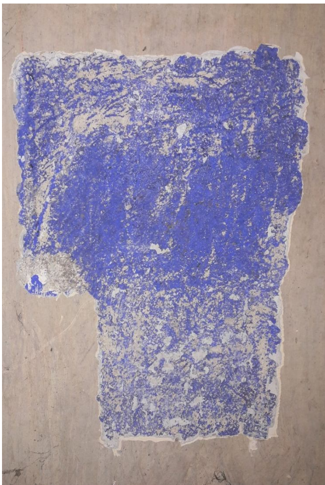
Fot. 3 Odkrywka na ścianie
