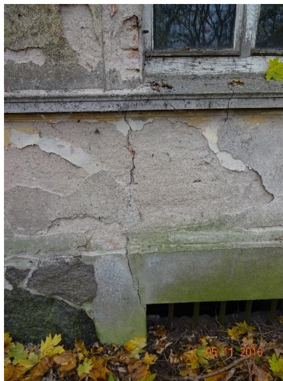
Fot. 6. Fot.7. Zarysowania fundamentów i ścian w części podpiwniczonej budynku
