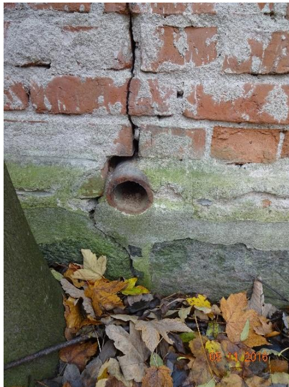
Fot. 4. Fot.5. Zarysowania fundamentów i ścian w części niepodpiwniczonej budynku
