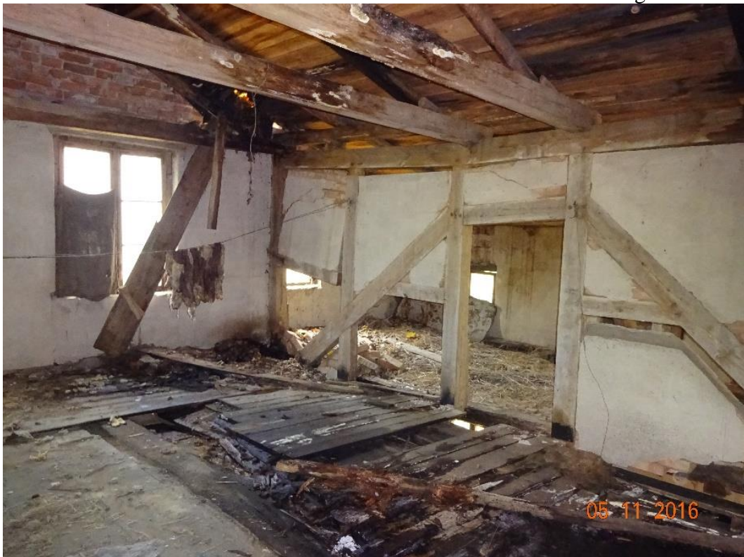
Fot. 21. Widok konstrukcji dachu budynku
