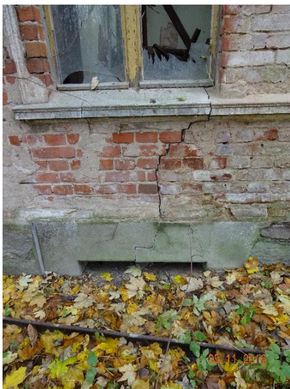
Fot. 6. Fot.7. Zarysowania fundamentów i ścian w części podpiwniczonej budynku
