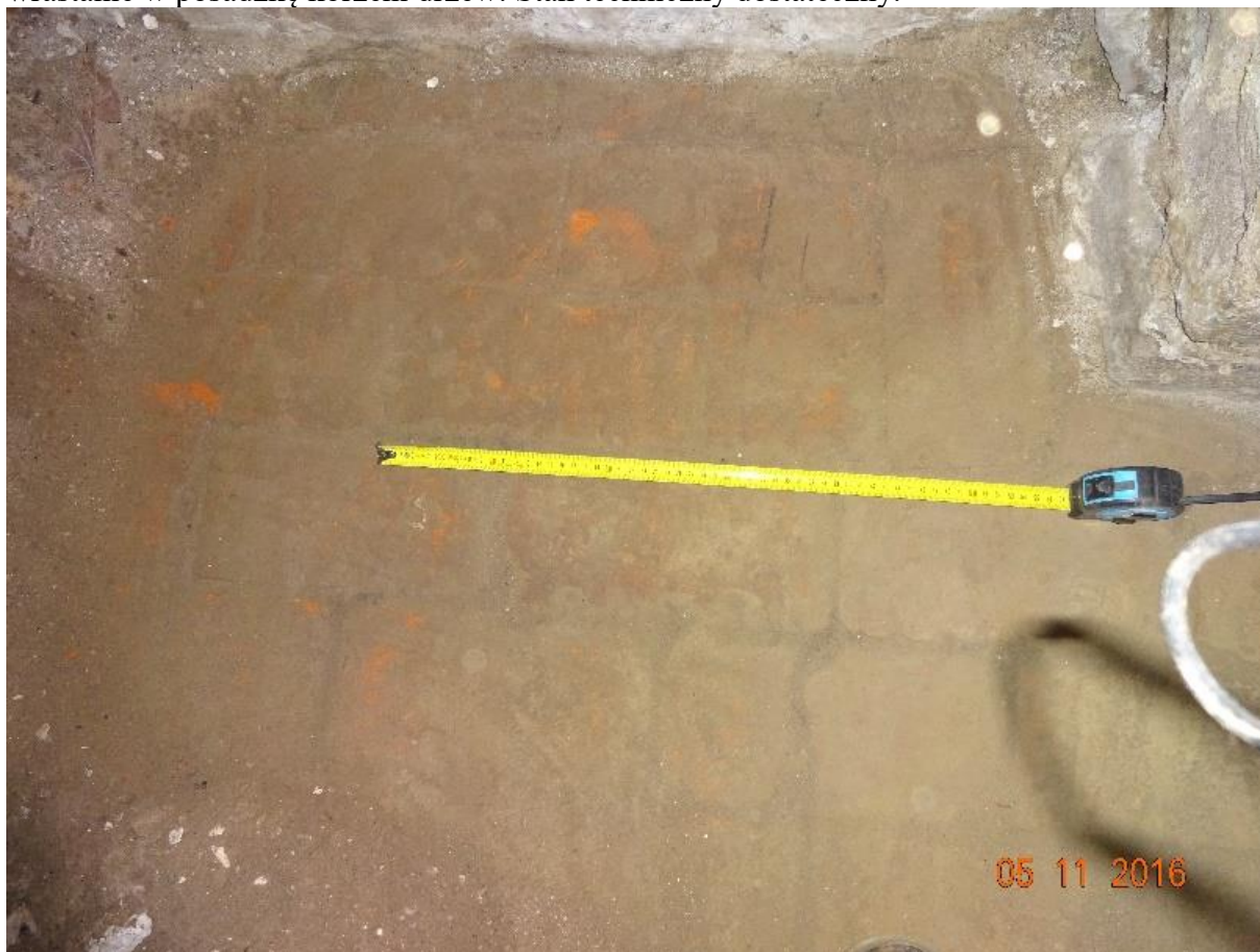
Fot. 9. Posadzka w piwnicy ułożona z cegieł na płasko na gruncie.
