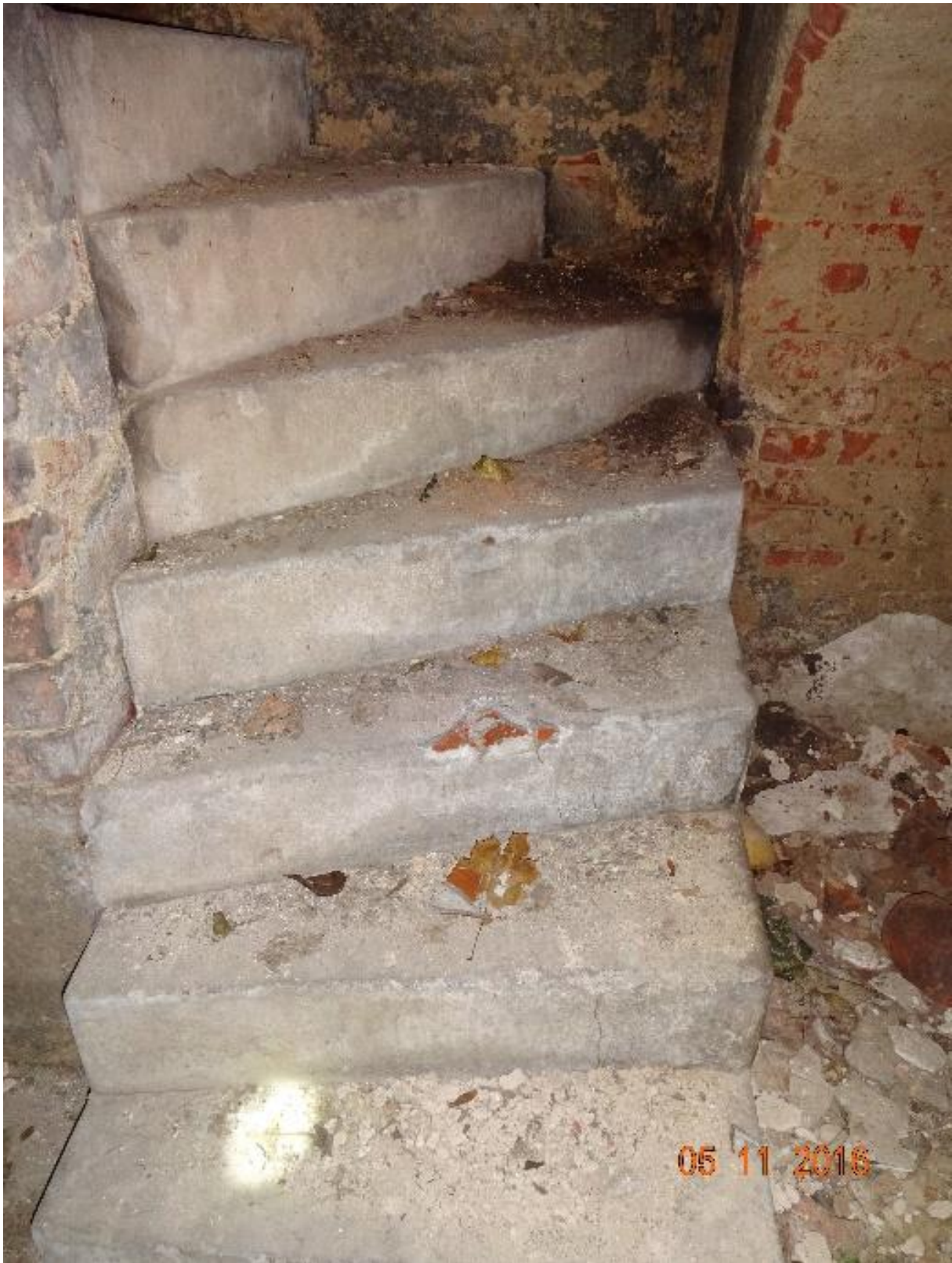
Fot. 11. Schody do piwnicy
