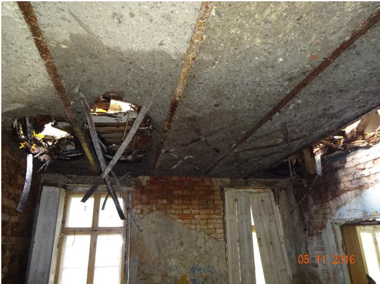
Fot. 18. Widok stropu betonowego nad parterem
