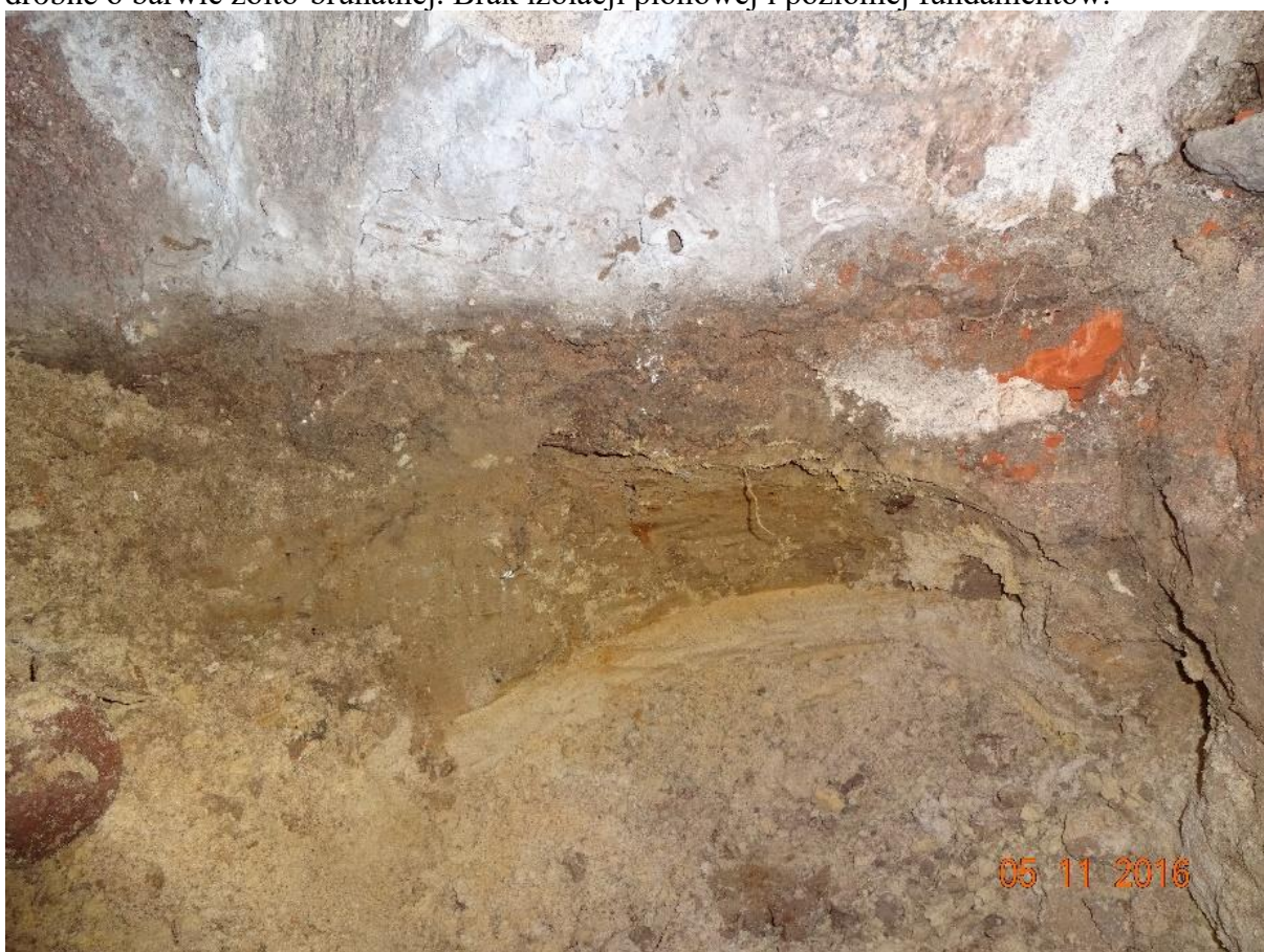
Fot. 3. Odkrywka podłoża gruntowego pod fundamentem
