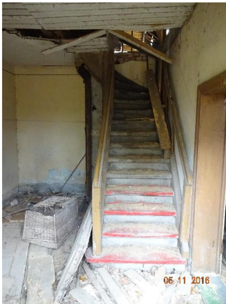
Fot. 19. Widok schodów na poddasze
