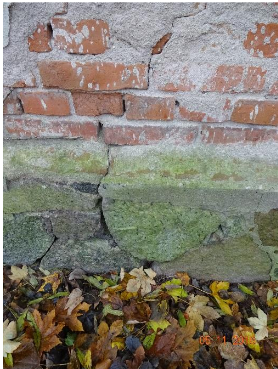
Fot. 4. Fot.5. Zarysowania fundamentów i ścian w części niepodpiwniczonej budynku
